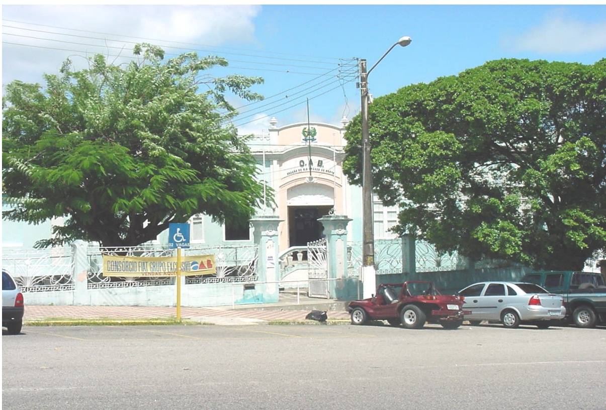
Figura 40 - Antigo Prédio do Congresso Estadual (atual sede da OAB/RN). Mapa 02 - C02. Foto: arquivo da SEMURB - Secretaria Municipal de Meio Ambiente e Urbanismo.
